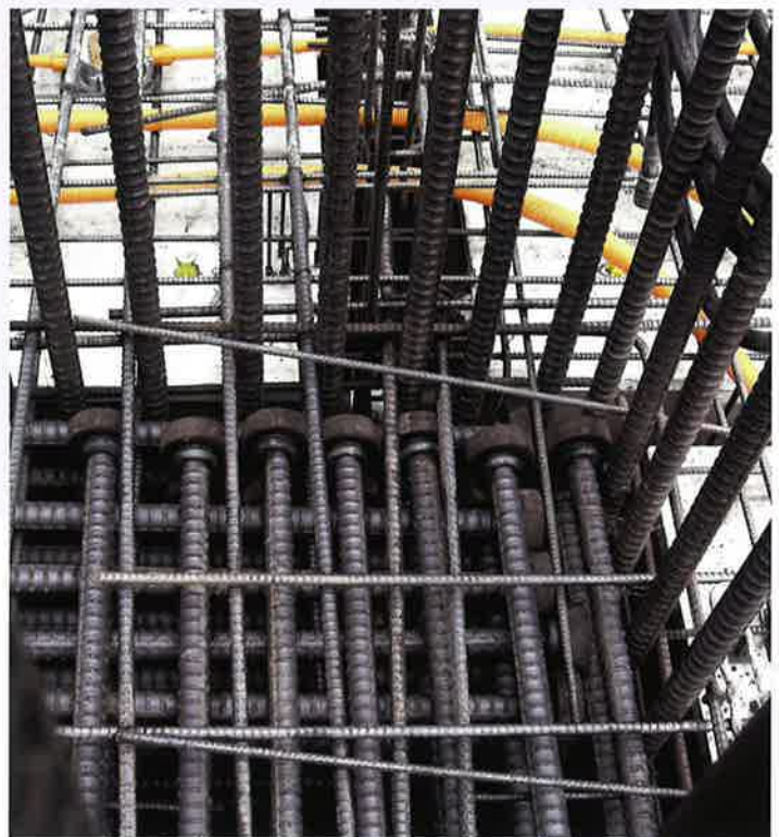
FRIP定着工法の配筋状況
